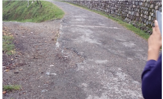
Fig. 4. Edge cracking
